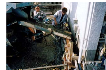
コンクリートを流し込みます
