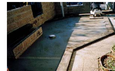
枕木で囲い・下地コンクリート
