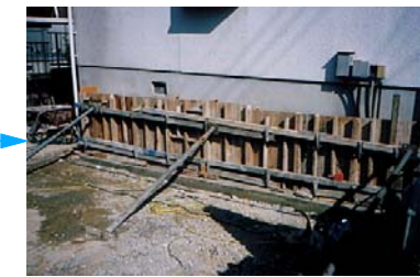
基礎を補強して駐車スペース
