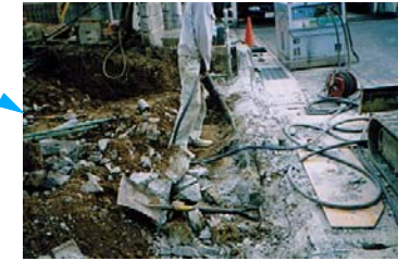
いらぬ擁壁の撤去
