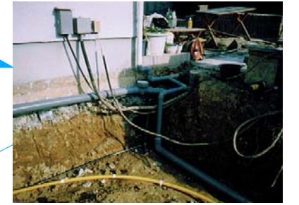
土を出した後は配管のやりかえ
