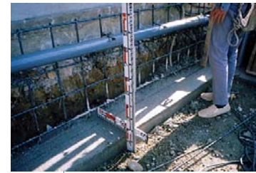
浮いた家の基礎の補強
