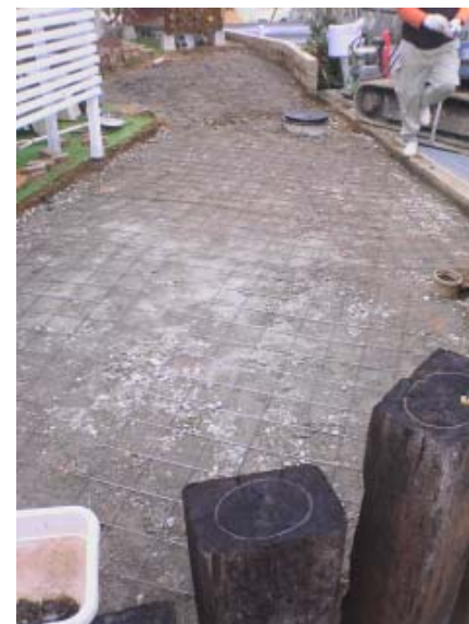
下地に碎石・金網を設置して コンクリート
